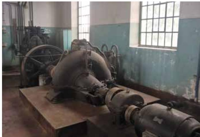
Strojnica črpališča je sestavljena iz dveh dvo-cilindrskih dizelskih motorjev in dveh črpalk. / La sala macchine è costituita da due motori diesel da due cilindri e due pompe. (Foto: Uredništvo / Redazione)
