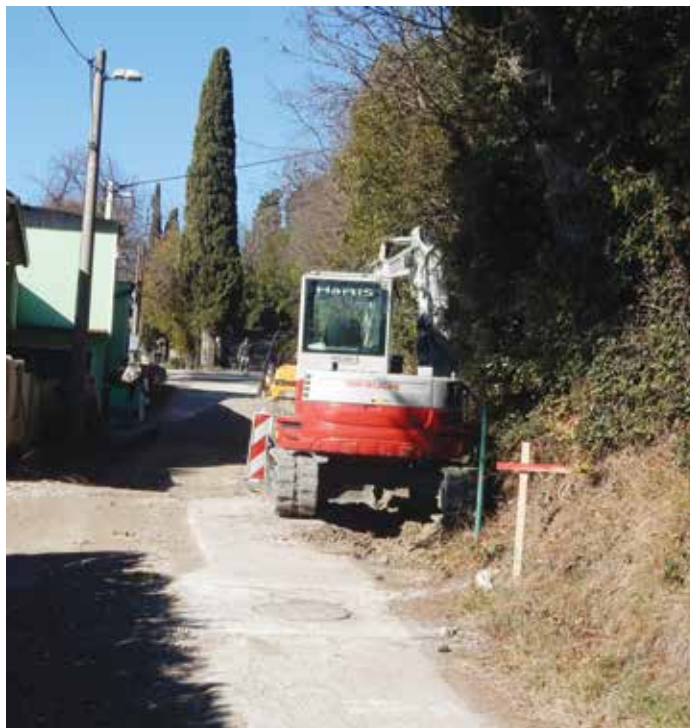
Delo na Vinogradniški poti bodo trajala približno 60 dni. / I lavori in Via dei Vigneti dureranno circa 60 giorni. (Foto: Občina Ankaran / Il Comune di Ancarani)
