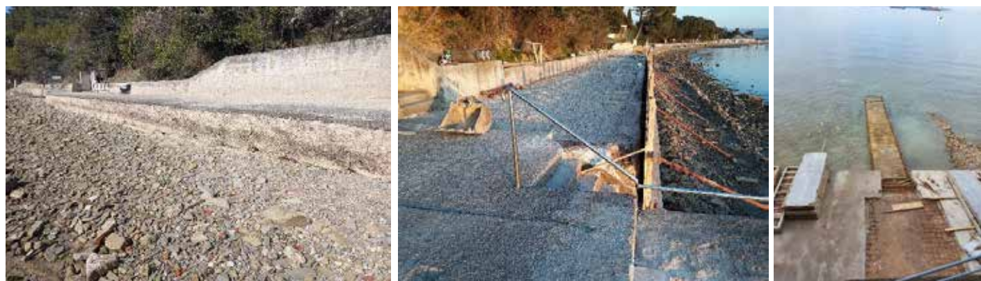
»Utujenost« stare betonske konstrukcije plaže Ankarančani in poškodbe po ujmi. / Stato della vecchia infrastruttura sulla spiaggia Ankarančani e i danni causati dal maltempo. (Foto: Uredništvo / La redazione)
