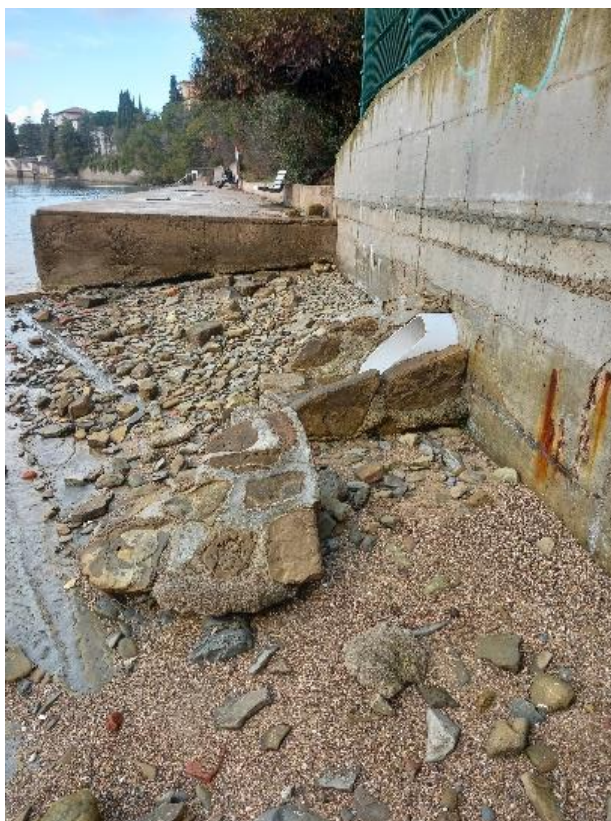
Slika 2.8: Poškodbe na dostopni rampi Ankarančani
