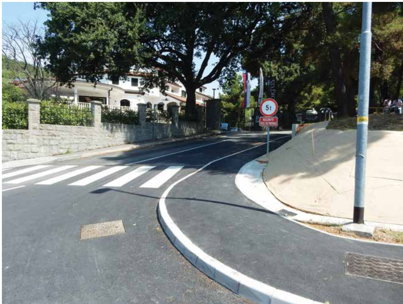
Občina Ankaran je pristopila k sanaciji priključka Razgledne poti na Jadransko cesto, kjer je izvedla razširitev priključka in novi pločnik s podpornim zidom. Foto: Občina Ankaran
