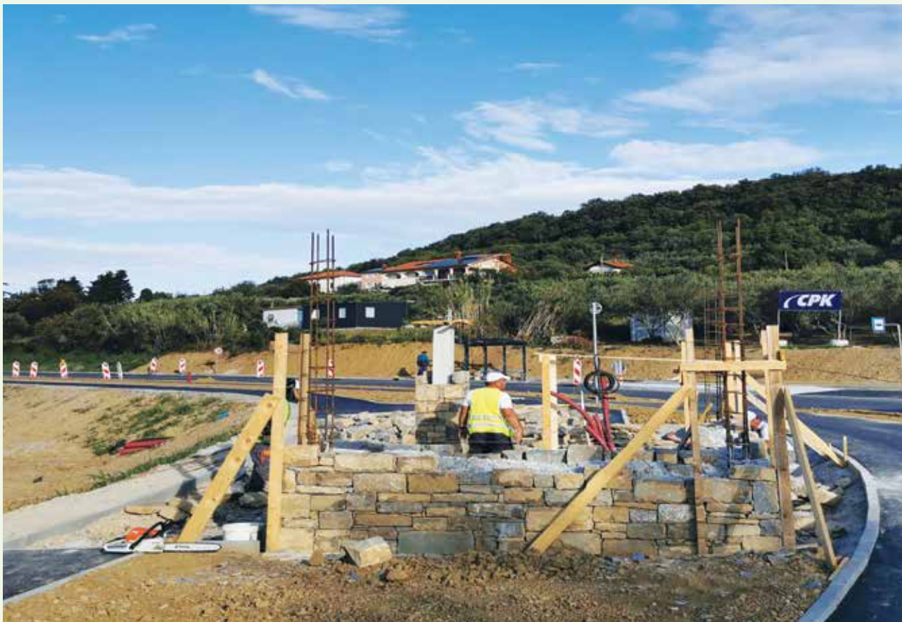
Gradnja kamnite istrske hišice, ki bo služila kot kolesarsko počivališče in razgledna točka. Foto: Občina Ankaran
