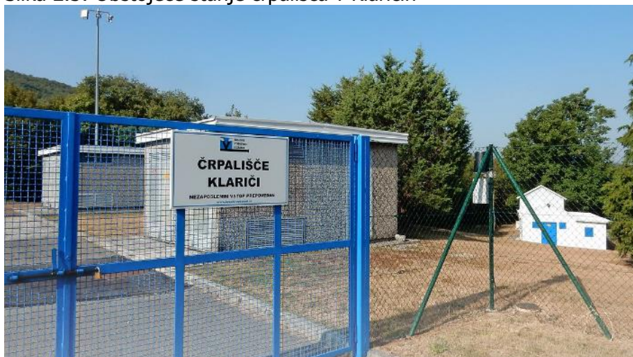
Slika 2.3: Obstoječe stanje črpališča v Klaričih
