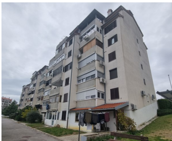
Slika 4: Večstanovanjski objekt na območju LP1 – J fasada
